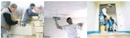
Rohbau Putz Estrich
