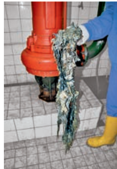
Sieht übel aus und ist es auch: verfilzte Feuchttücher. Regelmäßig legen sie Abwassersysteme lahm.
