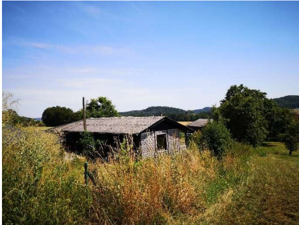
Abbildung 15: Ansicht von Nordwesten (eigenes Bestandsfoto vom 31.07.2024).
