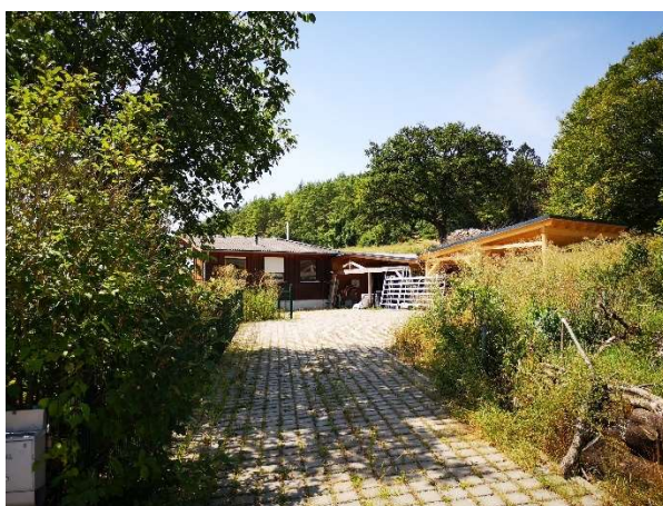
Abbildung 13: Zufahrt mit Rasenfugenpflaster (eigenes Bestandsfoto vom 31.07.2024).
