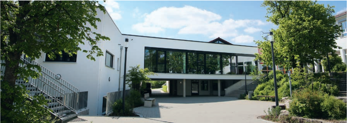
Von 2016 bis 2024 wurde die Schule Lauterhofen umfangreich saniert, erweitert und modernisiert.
