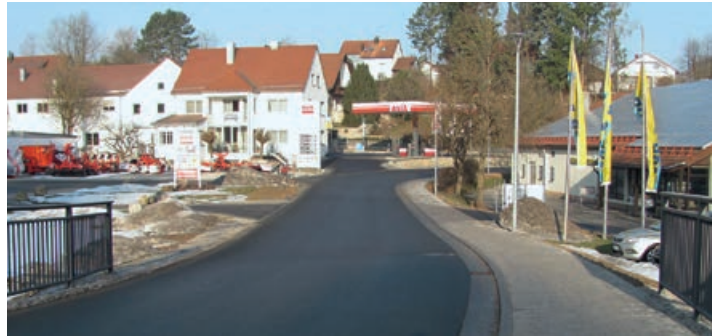
Sanierung der Neumarkter Straße.
