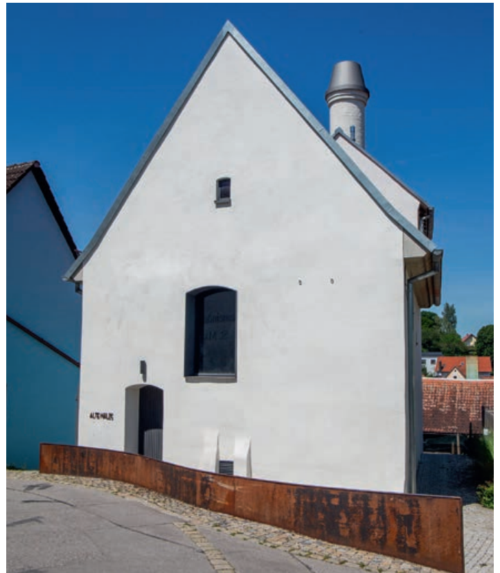
Umbau der Alten Mälze.
