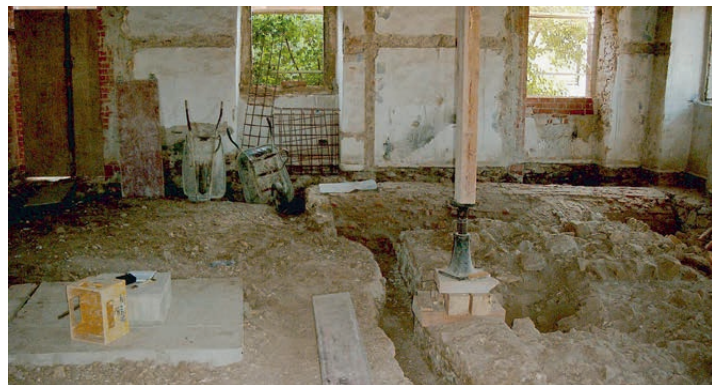
Der geöffnete Boden zeigte die historische Bausubstanz.
